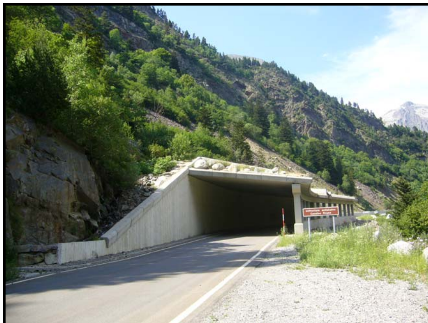
Figura 4.28.- Obra de defensa constituida por una visera en la zona de alud conocida como la Canal Roya, carretera de acceso al Hospital de Benasque (Foto: J.A. Ballesteros, 2006).
