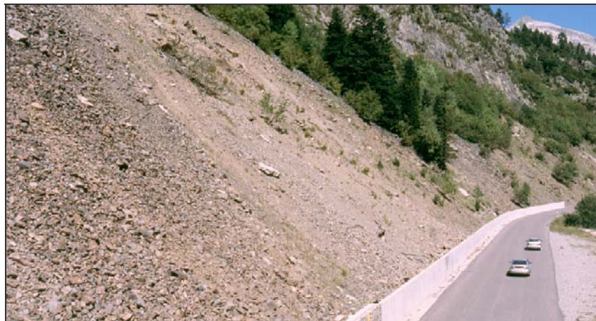
Figura 3.121.- Foto de un canchal activo y muro de defensa junto a la carretera que discurre por la margen derecha del valle del Ésera (Foto: F. Gutiérrez).
