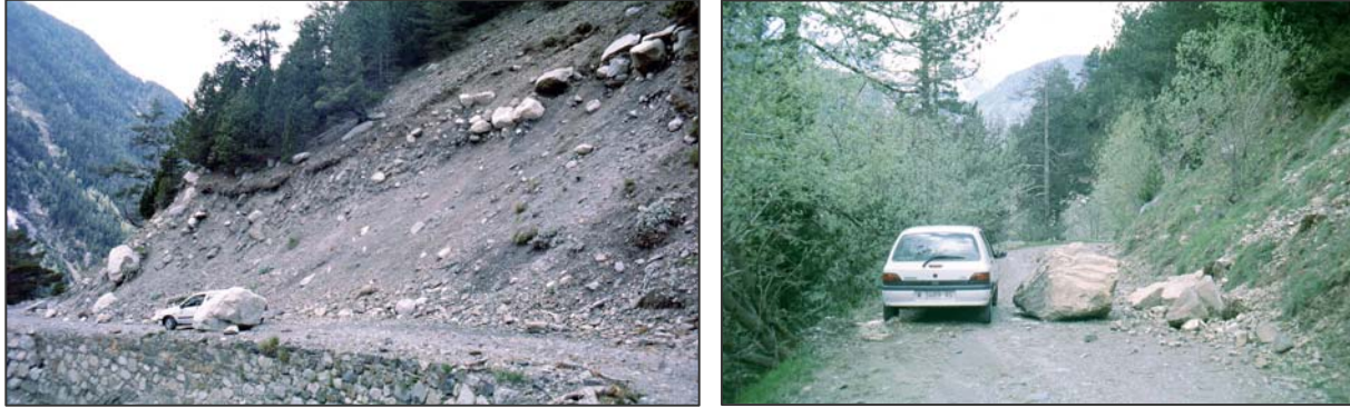
Figura 3.119.- Fotos de desprendimientos de rocas individuales en la pista forestal de Vallibierna (Fotos: E. Acosta)
