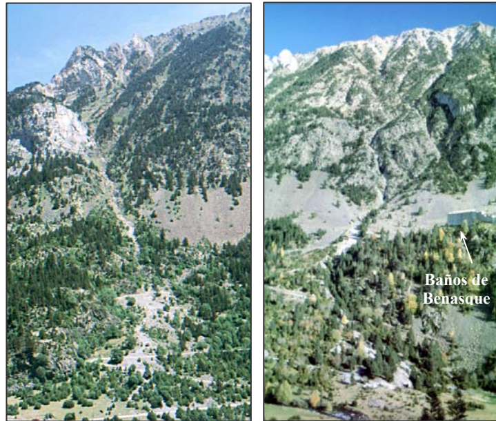
Figura 3.62.- Fotos de debris flows por espesamiento de la escorrentía en canales de avalancha afectando al acceso a los Baños de Benasque (Fotos: E. Acosta).
